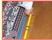
床の傾き調査
